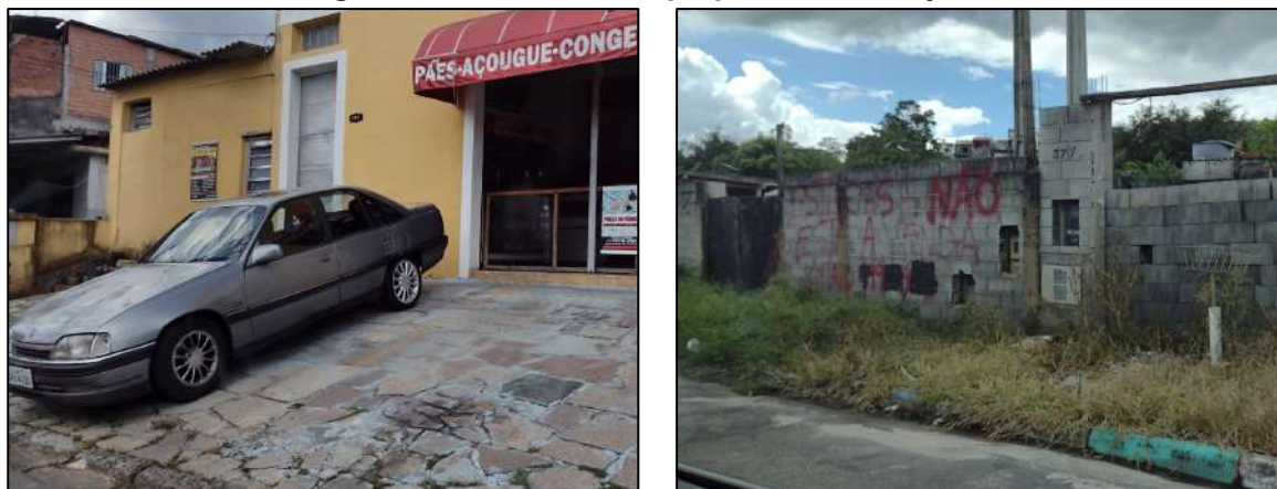
Figura 104 – Calçadas inapropriadas em Arujá/SP.
