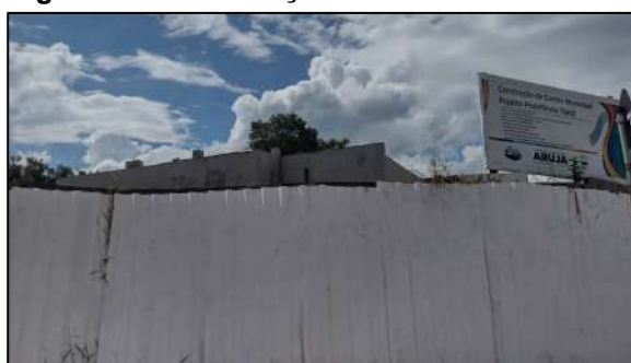
Figura 56 – Construção Creche Pro Infância.
